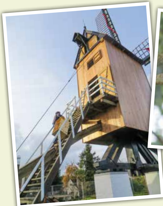
Plaatsing kerkuilenbak Westermolen Lembeke
